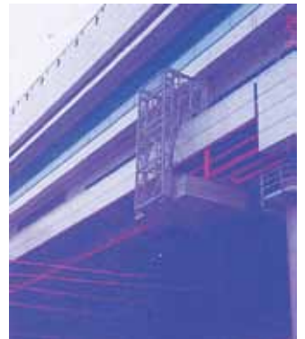
▲JR千葉駅：水平移動式点検作業台
