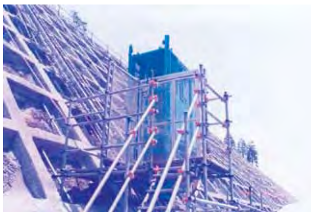
ユニット化されたエレベータシャフト
