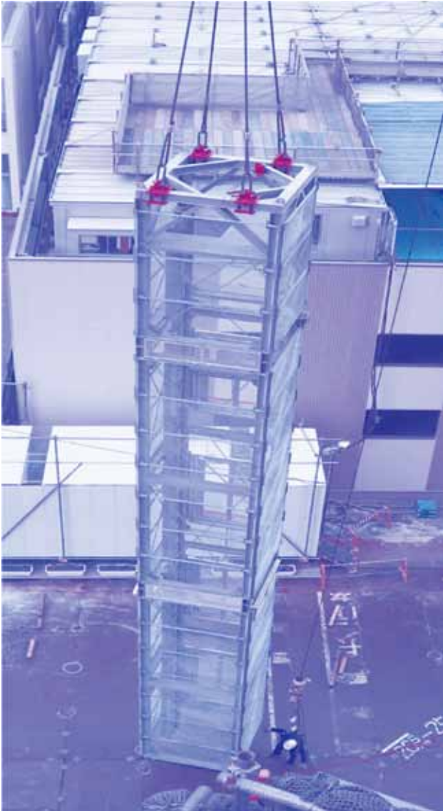
組立時の上部ユニット側（中間2、上部1）吊上げ状態
