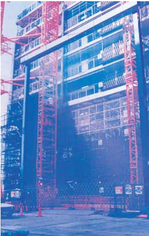
▲野村・八千代作業所：大型リフト開口部遮断装置
