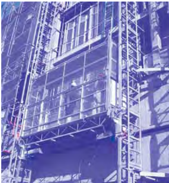
工事用エレベーター
