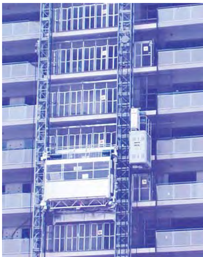
2 t 長尺ケージ(左)と0.98 t 箱型ケージ(右)が単独運行可能
