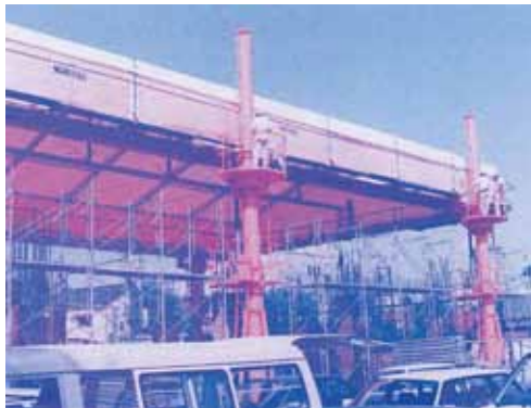
▲浅倉ビル新築工事業所：全天候式屋根クライミング装置
